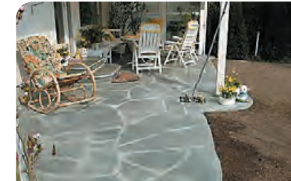
▮ Komplettsanierung einer denkmalgeschützten Trockenbaumauer ▮ Natursteinterrasse polygonal Verband
